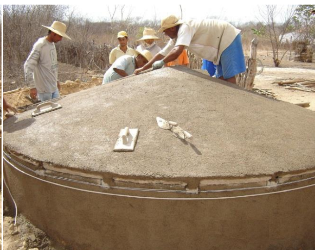
Traço: 5 latas de areia para 1 de cimento
