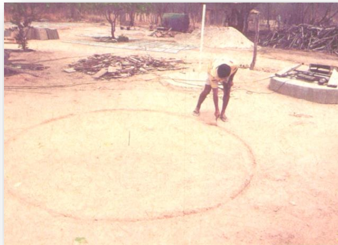
Figura 3: Marcação da área da cisterna
