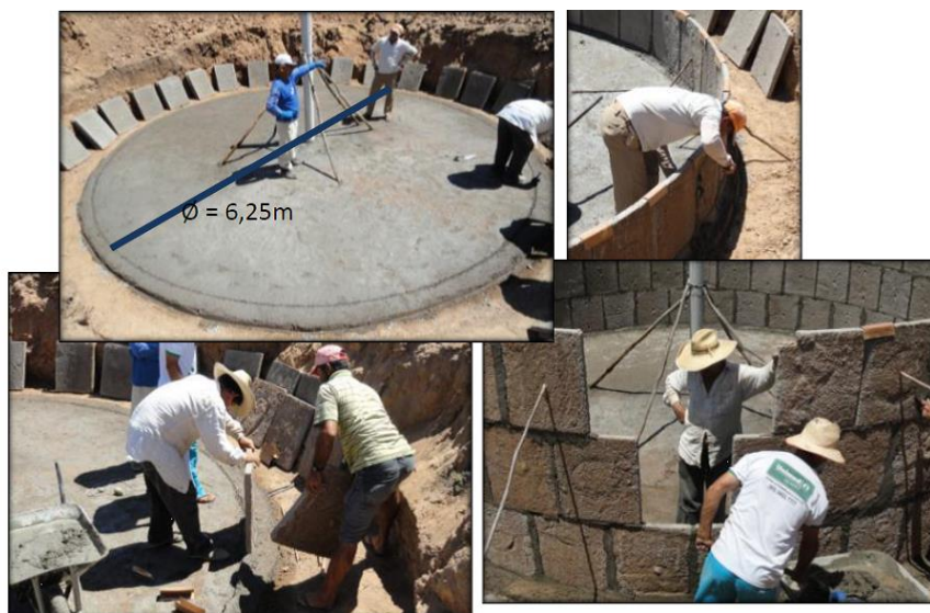
Figura 10: Construção da parede da cisterna
