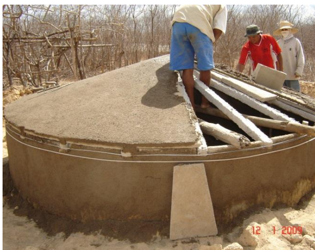
Traço: 5 latas de areia para 1 de cimento
